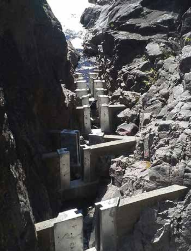
Rivière Moisie. Vue d'ensemble des murets avec les plaques de protection. Photo : APRM
