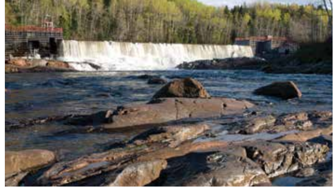
Rivière Escoumins. Barrage avant les travaux. Photo : Yves Demers
