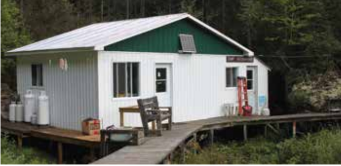
Rivière Moisie. Rénovation du camp de gardiennage. Photo : APRM
