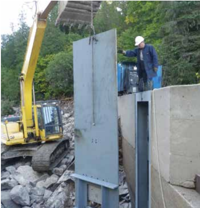
Rivière Ste-Marguerite. Installation de la vanne. Photo : AECOM
