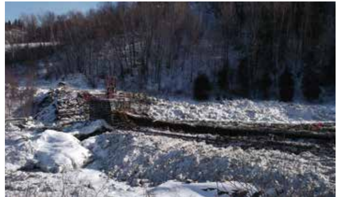
Rivière Escoumins. Démantèlement du barrage. Photo: Sylvain Gagnon
