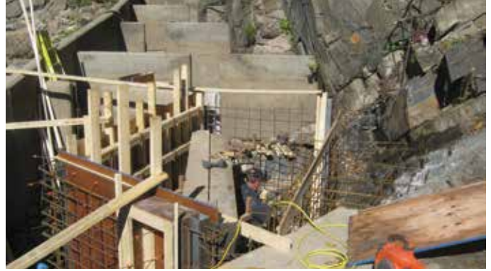
Rivière Ste-Marguerite. Construction des formes du bassin de stabulation. Photo : AECOM
