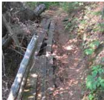
Rivière Mistassini. Remplacement d'une structure existante. Photo : OBVM
