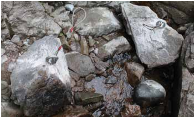
Rivière Moisie. Roches de plusieurs dizaines de kilogrammes percées et câblées prêtes à l'opération d'élingage avec l'hélicoptère. Photo: APRM
