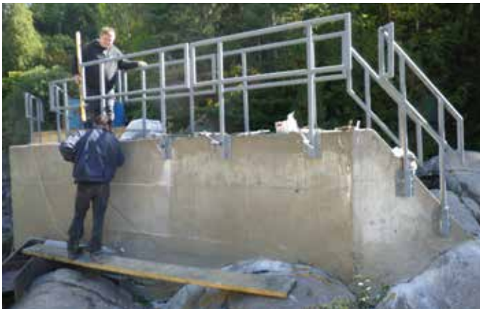
Rivière Ste-Marguerite. Pose du garde du corps vanne. Photo : AECOM
