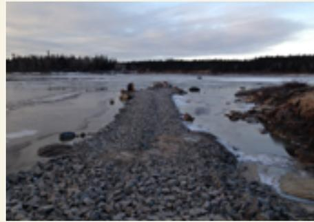
La première phase des travaux est l'excavation d'un canal de contournement en vue d'aménager, en 2016, une succession de quatorze bassins et seuils, suivi d'un canal de contrôle du débit, qui permettra au saumon de franchir la chute. Un chemin d'accès à la rivière et une rampe de mise à l'eau ont été construits, l'équipement lourd est transporté sur une barge et le canal de la passe excavé de l'aval vers l'amont par forage et dynamitage contrôlé.
