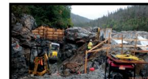
**Consolidation des parois rocheuses à l'aide d'un treillis de haute résistance**
