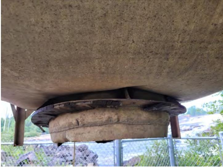
Photo 9. Déformation du fond de la cage à proximité du bouchon
