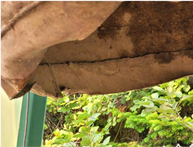
Photo 10. Arceau sous la cage abimé, créant des arrêtes métalliques vives
