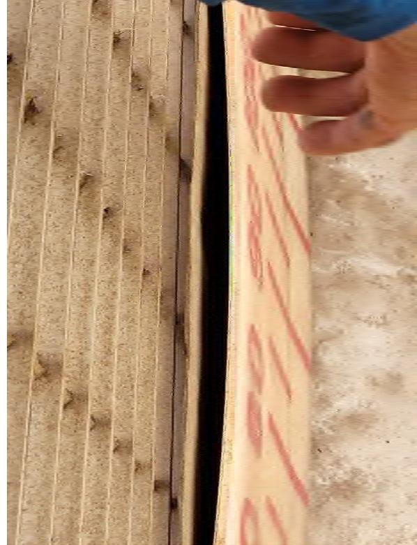
Photos 11 et 12. Règle de mesure en mauvais état et mal fixée aux bordures latérales.
