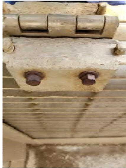
Photos 7 et 8. Grillage de la cage avec arêtes vives et pentures à l'intérieur de la cage.
