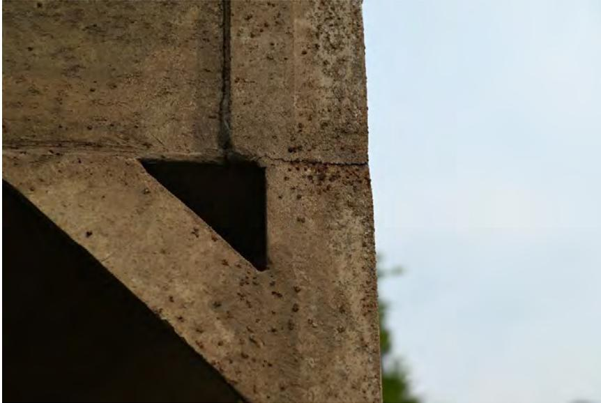
Photo 13. Fissure à réparer à une des pattes de la cage 1
