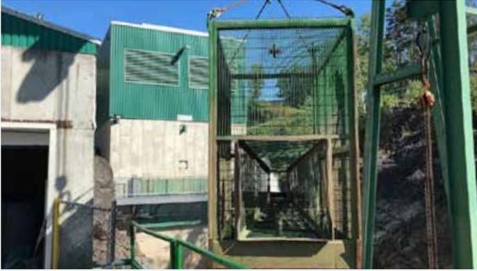
**Figure 3 :** Piège de capture aménagé au niveau de la centrale hydroélectrique Boralex permettant d’intercepter et de dénombrer les saumons en montaison
