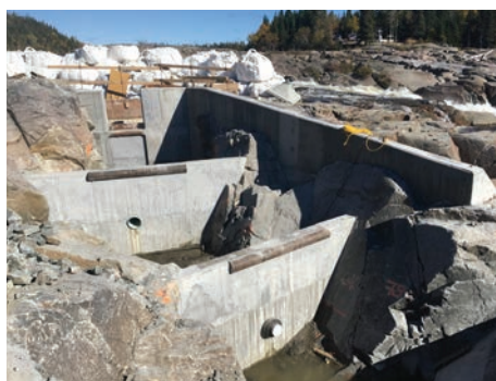
Batardeaux et seuils
