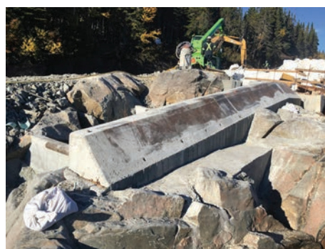
Muret de protection
