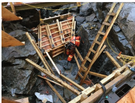
Mise en forme des structures
