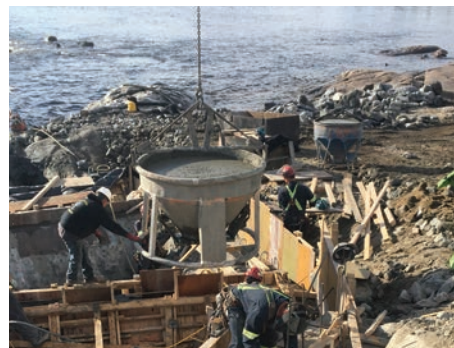
Bétonnage des structures
